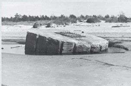
▲ Фундамент под орудия батареи на острове Ягеры. 1947 год. В годы войны на таких основаниях располагались 152-мм орудия системы КАНЭ
